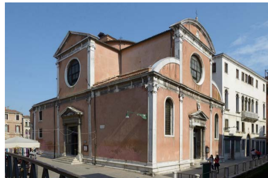
Chiesa di San Felice along Strada Nova. Photo: Wolfgang Moroder.
